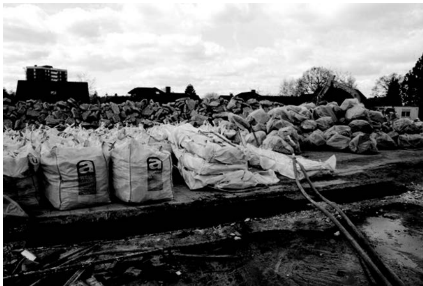
Abb. 6: Ordnungsgemäße Verpackung schadstoffhaltiger Materialien und Bereitstellung zum Abtransport 47
