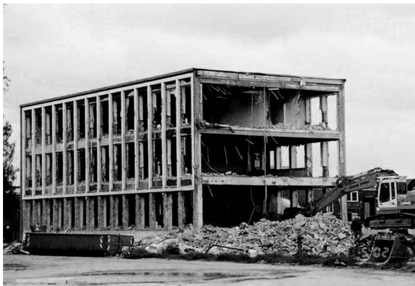
Abb. 8: Komplett entkerntes Gebäude
