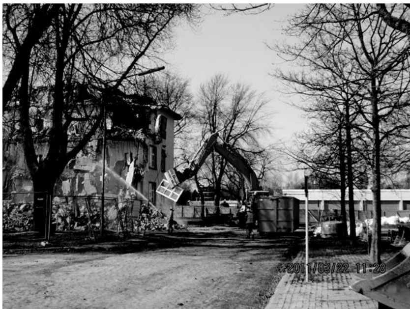
49 Abb. 7: Vorlaufende Separierung von Einbauten (hier: Fensterflügel)
