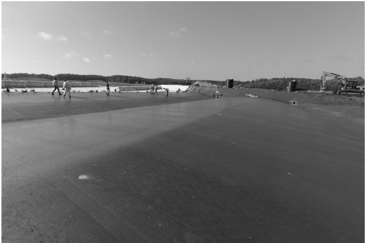
Abbildung 10: Abdichtungsbau im MFA-BA2-West im September 2013 (im Vordergrund erkennbar ist die vorbereitete Oberfläche der Mineralischen Dichtung mit dem überhöht hergestellten Quergefälle)
