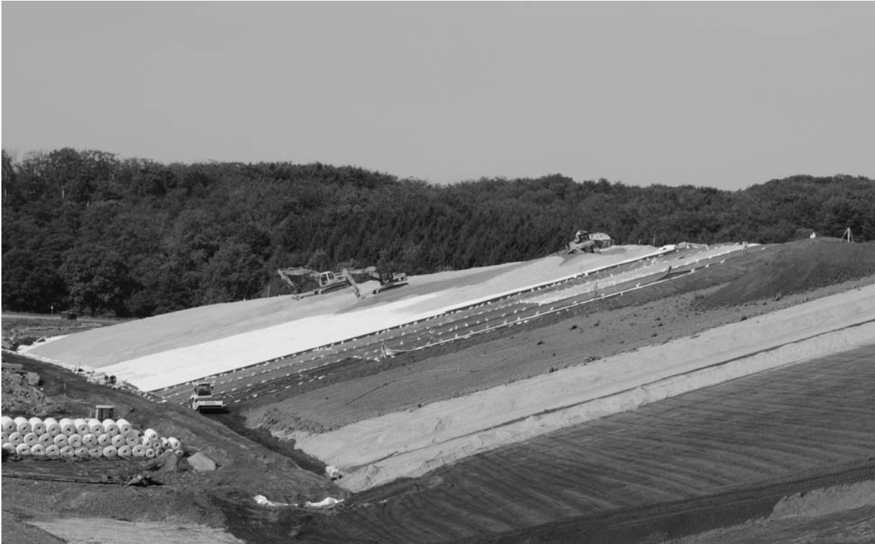
Abbildung 9: Abdichtungsbau im MFA-BA1-West im August 2012 (in der hinteren hellen Fläche ist die Sandschutzbahn und darüber der Einbau der Entwässerungsschicht erkennbar)
