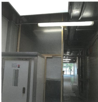
Schwarzbereich für das Trennen einer Asbestzementleitung
