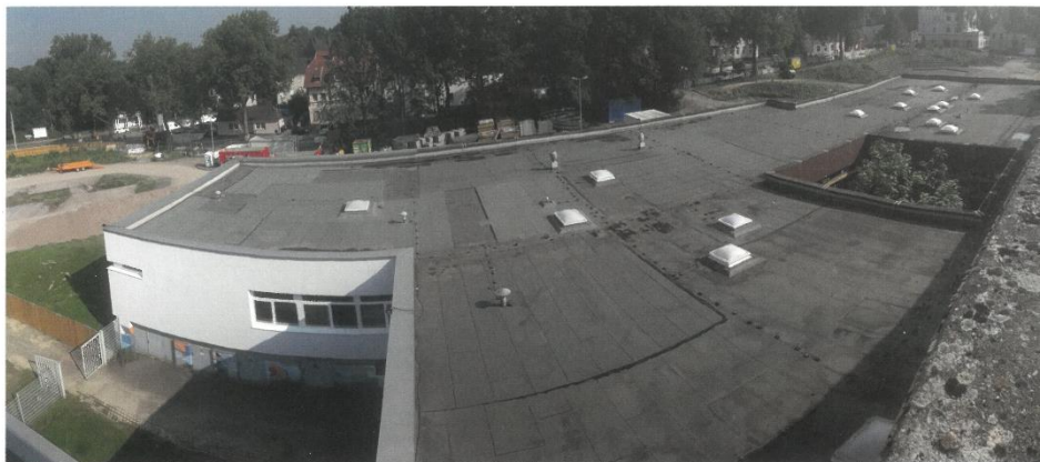
Panoramablick auf den abzubrechenden Gebäudeteil des 1. Bauabschnitts
