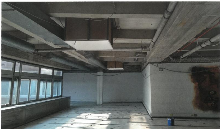
Gereinigter Schwarzbereich in der ehemaligen Schulbibliothek nach Rückbau der Abhängecke mit asbesthaltigen Spachtelmassen. Hier entsteht später das Lehrerzimmer.
